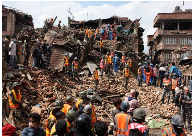
Krisenbrennpunkt Nepal. Hilfskräfte von Rotem Kreuz und Rotem Halbmond arbeiten sich im Bhaktapur-Distrikt durch die Trümmer nach dem verheerenden Erdbeben vom 29. April. SALENDRA KHAREL / INTERNATIONAL FEDERATION RED CROSS / HANDOUT
